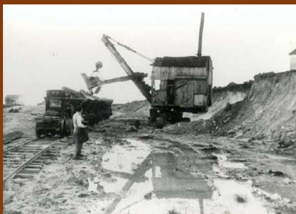
construcción de la línea ferroviaria
