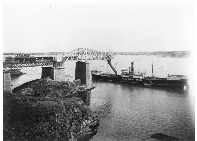
El cargadero de la costa de Lugo (Ribadeo)
